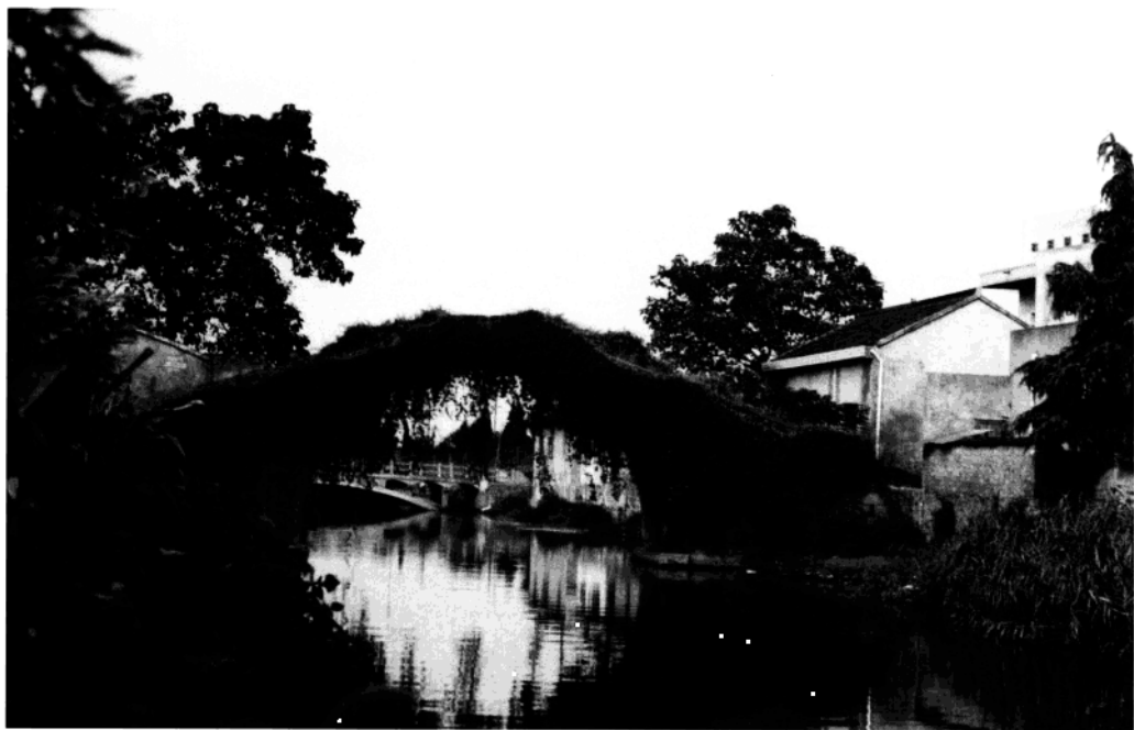
1-8 临平龙兴桥 (2002 年) [余]
