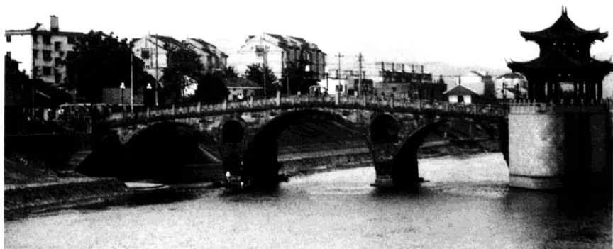
1-4 古貌依旧的苕溪通济大桥 (2006年) [赵藏]
