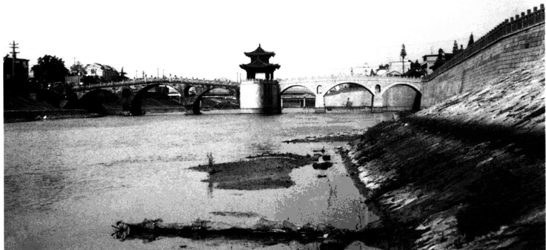
1-3 河道拓宽、桥梁加长之苕溪通济大桥全貌 (2006年) [赵藏]
