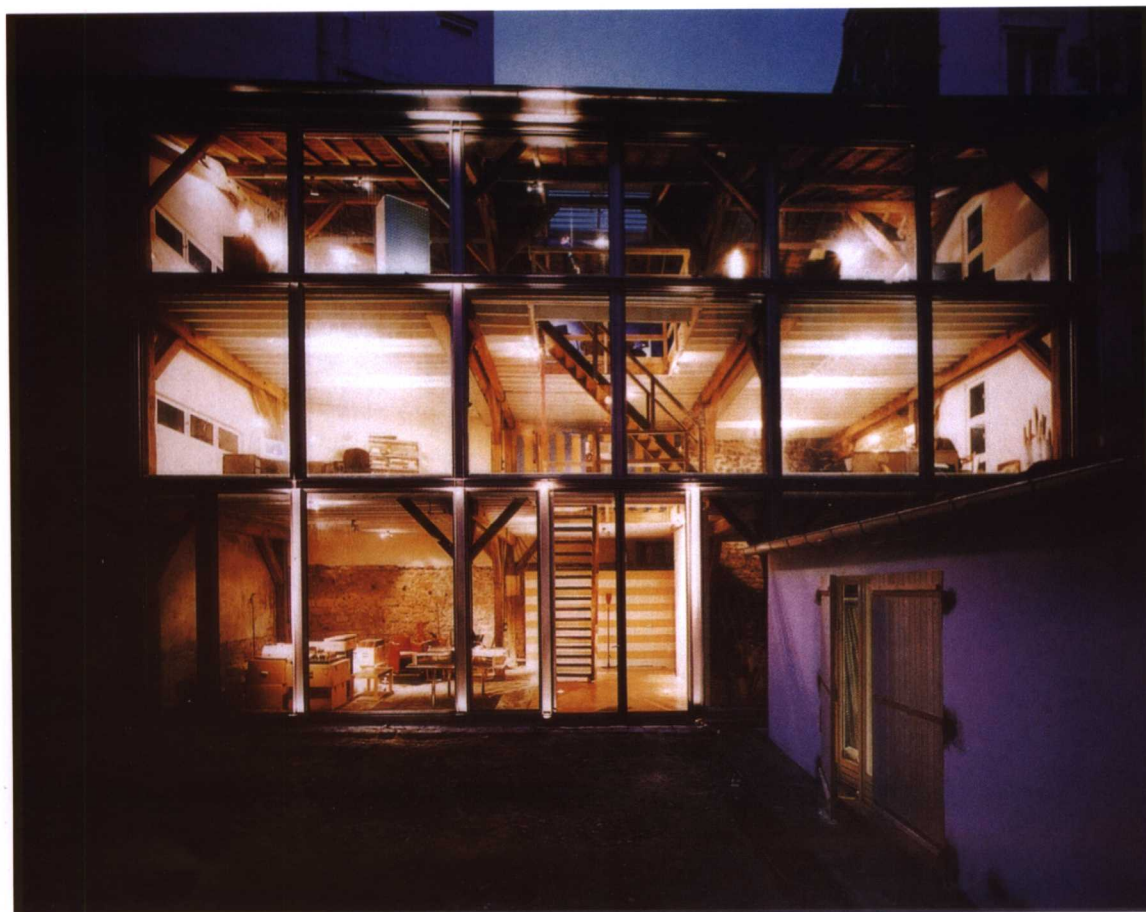
这是一座老仓库改成的办公室，家具和整个结构都显示出崇尚质朴的设计原则。图为办公室夜景。
