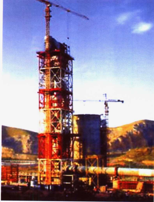
河南新乡水泥熟料生产线设备安装工程
