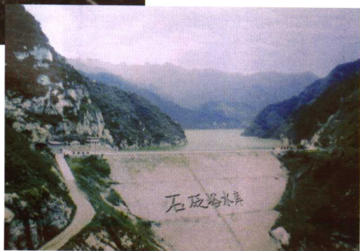
① 陕西瀉河石砭峪水库大坝
