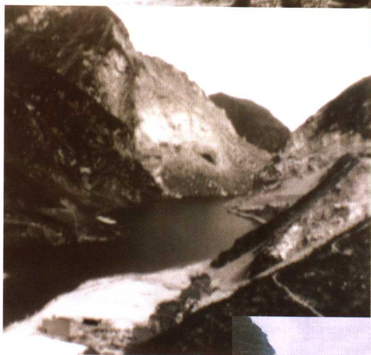
① 陕西瀉河石砭峪水库爆破堆石雏形
