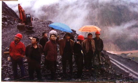
陈刚毅（左二）在角笼坝大桥施工现场
