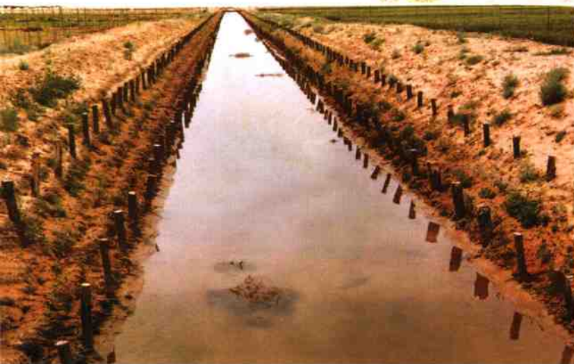
▼ 马太沟乡沟道滑坡治理
