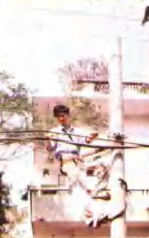
▽白粉壁电话村在建设中
