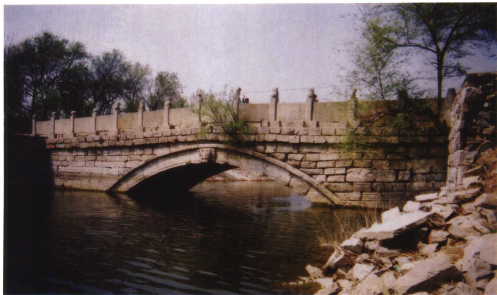
横跨平阴浪溪河上的明代石桥——永济桥，以造型生动、形态各异的栏板柱头石狮为胜。(2004年摄)
