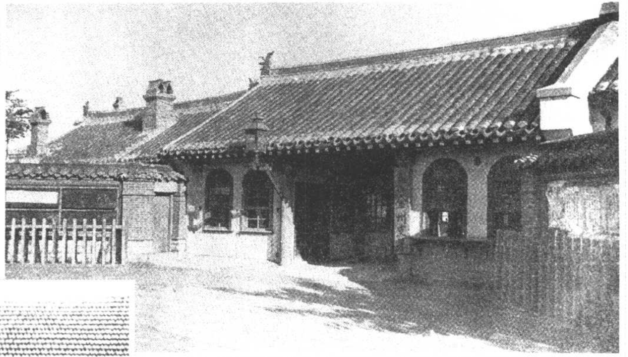
关东厅金州民政支署。
