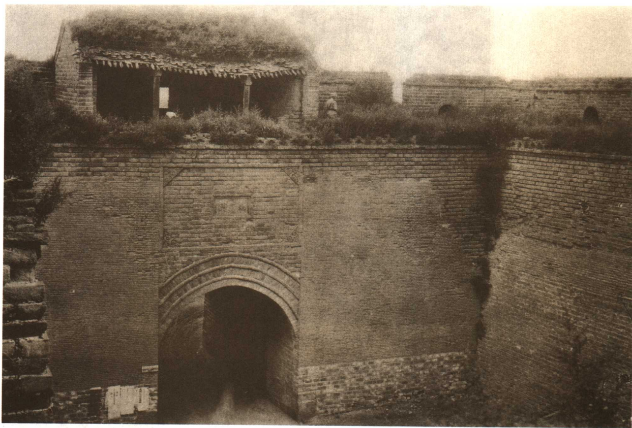
图 4-839 沈阳城小北门门拱 辽宁省沈阳
