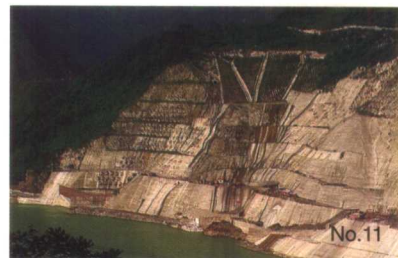
1、2号泄洪洞出口高边坡
