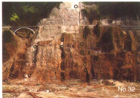
左岸煤洞分布情况
