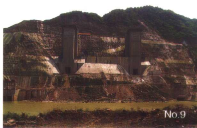
1号、2号泄洪洞进水口
