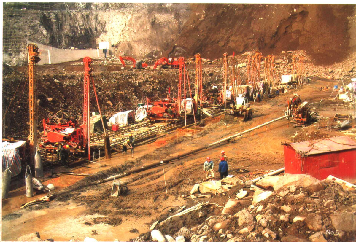
围堰防渗 墙施工
