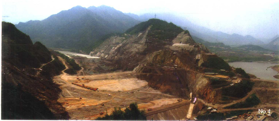
大坝开挖填筑
