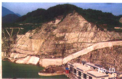
施工处理完成后的溢洪道高边坡
