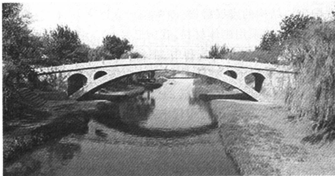
图1-2 河北赵县安济桥
