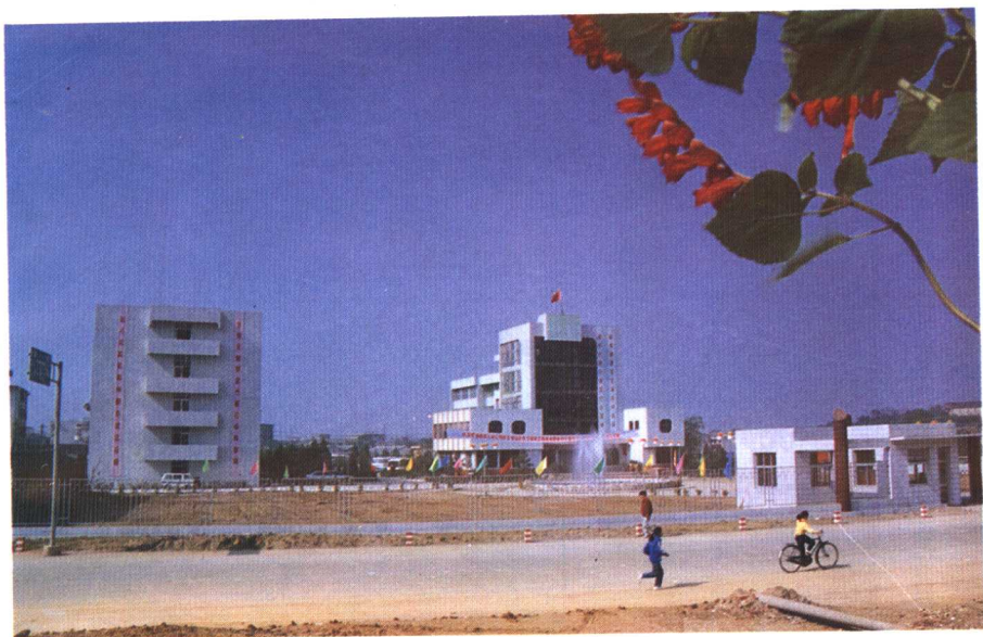
大港经济开发区、镇人民政府办公楼
