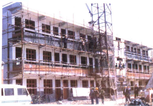
丹徒县第三建筑工程公司工地
