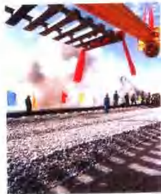
青藏线第一轨排铺设场景
