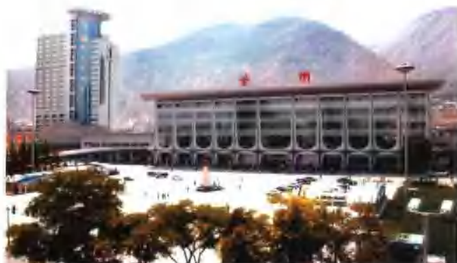
扩建改造后的兰州新站舍
