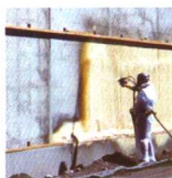
聚氨酯现场 喷涂施工
