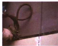
现场浇注 聚氨酯施工
