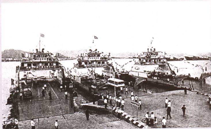
80年代建设的汕头西堤车渡码头。
