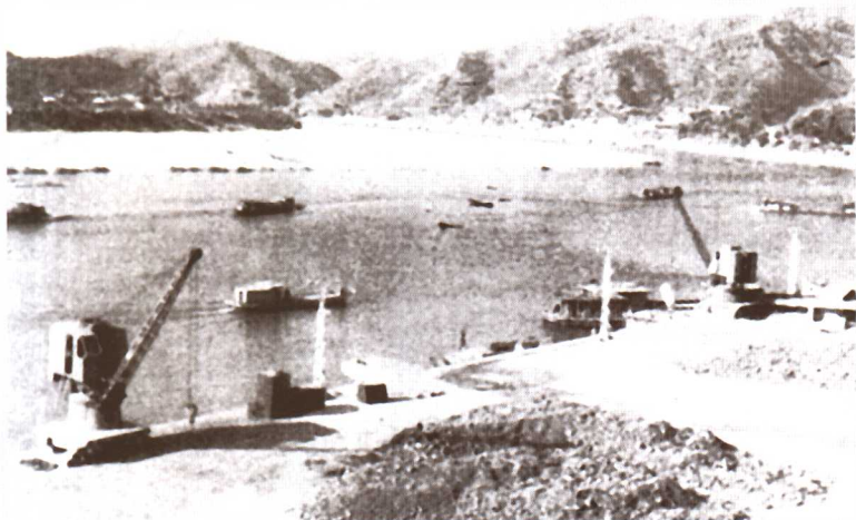
1972年起陆续建设的位于北江和连江汇合处的英德连江口港，是北江水系中最重要的中转港口。
