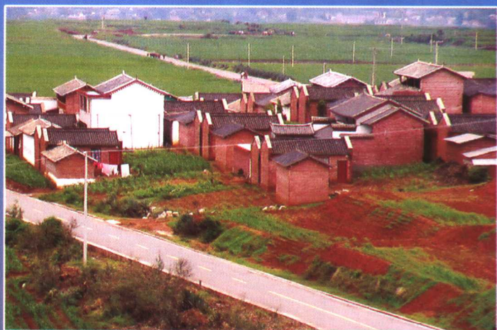
“7·21”、“10·16”地震民房恢复大坝子统建点
