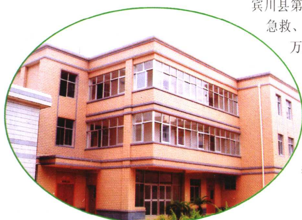
县第一人民医院传染病区业务综合楼
