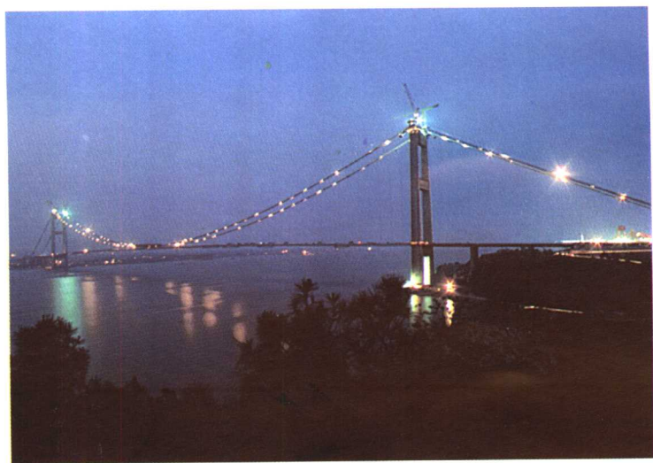
江阴长江公路大桥
