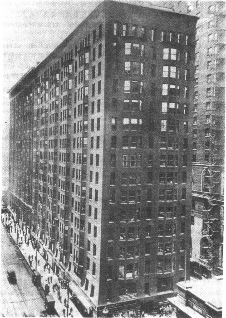
图表 1-2 芝加哥残留的建筑物（1891 年 Burnham 和 Root 设计师）， 最后一座未加固的高层砌体建筑
