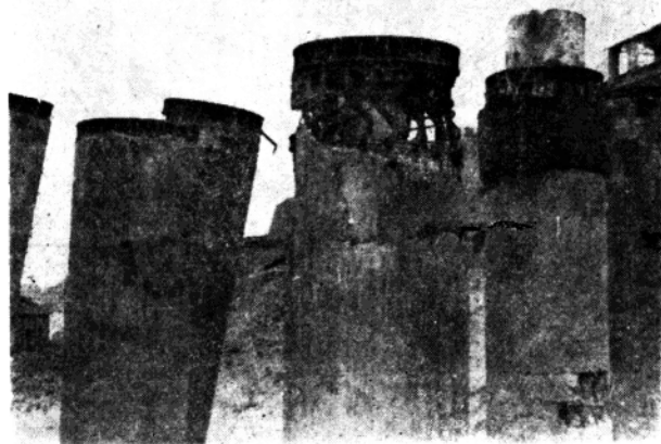
图11 #33墩用11-B-3复打汽锤打桩打完后的桩头情况
