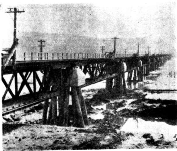
图2 排架式高桩承台
