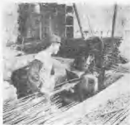
圖3 鋼筋彎切
