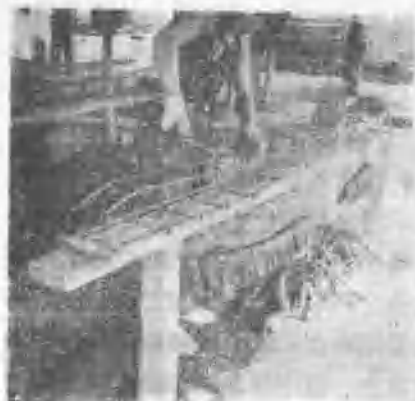
圖10 編鋼筋架
