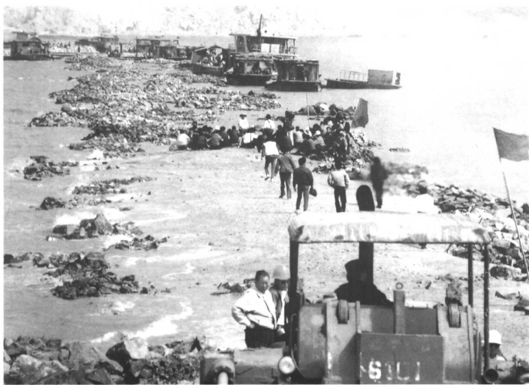
图21 • 1990年南水至高栏连岛大堤工程的施工现场。 (杜国志 供稿)
