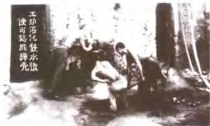
根据地人民积极生产武器弹药支援抗战。图为今郊区任家峪村民众采用土炉熔铁铸造手榴弹壳
