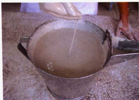
9. 最后形成比较均匀黏稠的石膏浆。浆应该能够糊在手上并具有一定的流动性。
