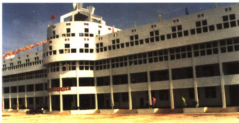
潮阳谷饶中学教学大楼。
