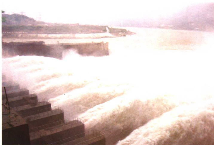
投入运行的深孔正在泄洪
