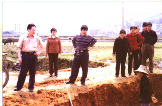
图为局领导班子成员到城关镇鞍山社区交椅屯察看农田水利维修情况，并扶助6吨水泥用于该屯水利维修。
