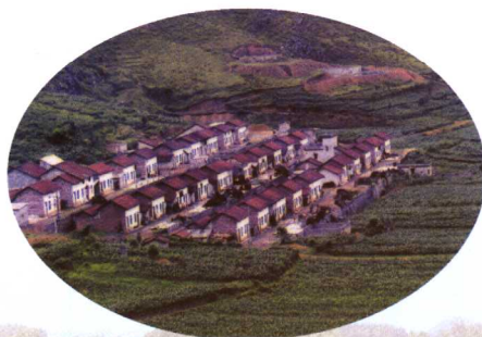
←忻城县大塘镇扶贫异地安置新村面貌。
