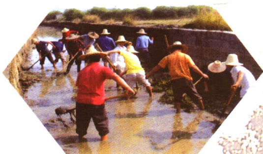
↑江平渠道水毁修复工程。
