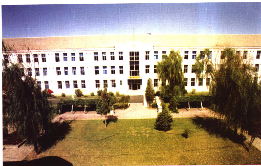
▲ 抚顺矿务局职工工学院教学楼
