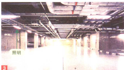
在停车场和机械室中，照明器具沿电线管的走向低空布置，既明亮又易于管理。
