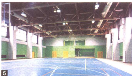
图5是体育馆的例子，设置了自动升降装置，照明可通过电动控制自动升降。
