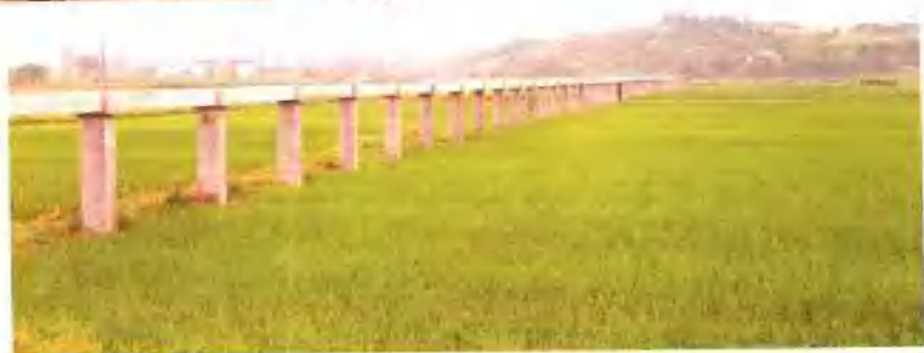
下马渡镇渡槽
