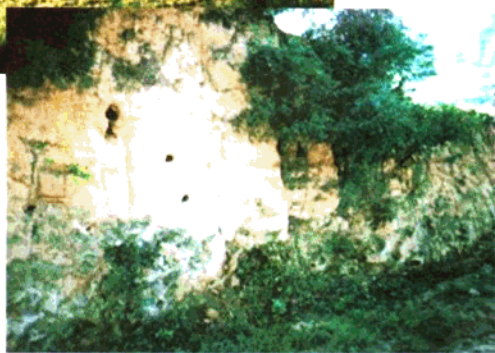
▲ 晋都——聚（车厢城）城墙横断面，厚十米，夯土层明显。
