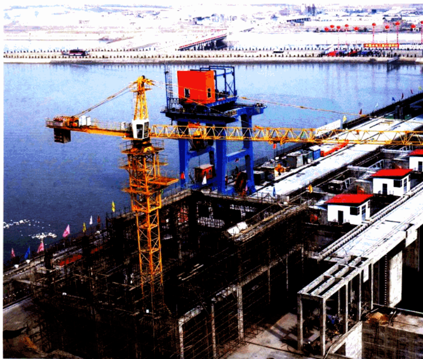
2003年12月，黄河沙坡头水利枢纽主体工程建成
