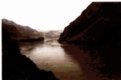
黄河黑山峡大柳树水利枢纽坝址
