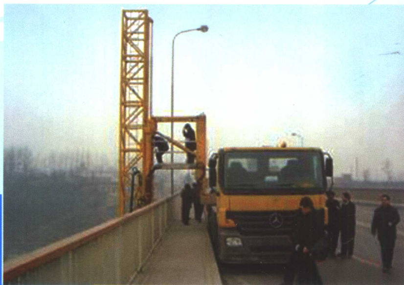
桥梁养护检查
