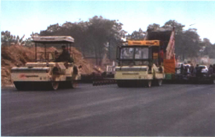
运用先进机械 进行路面养护作业
