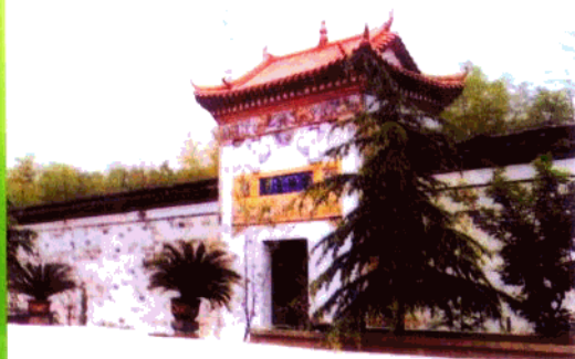
清代乾隆年间重修的云峰寺门楼
