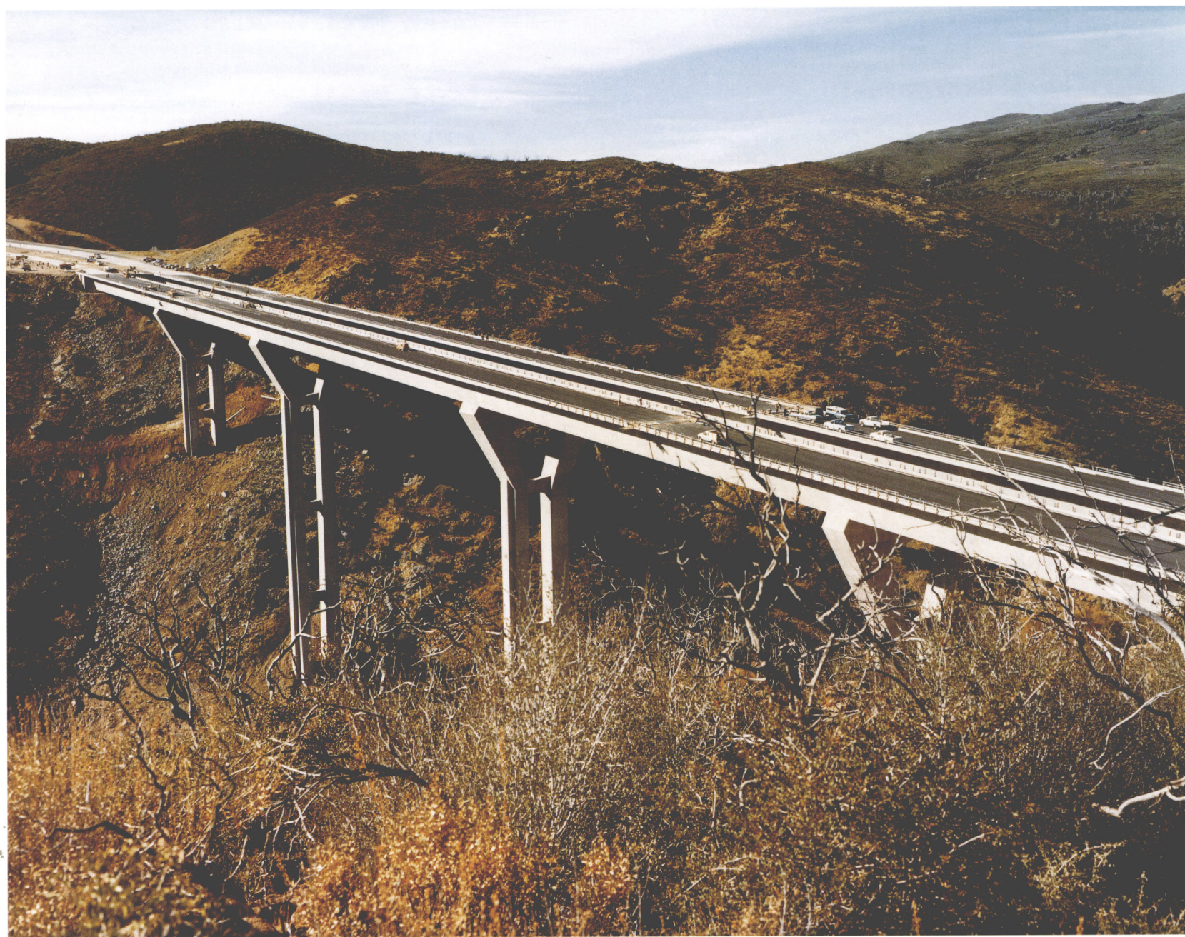
松谷溪 (Pine Valley Creek) 桥，加利福尼亚
