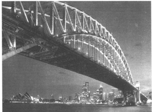
图 1-1-3 澳大利亚悉尼港中承式桁架钢拱桥(1932年)
