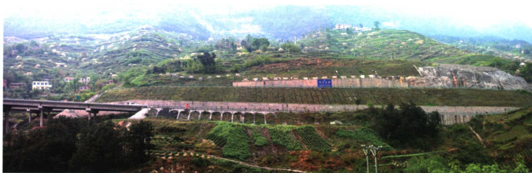
竣工后的万梁高速公路张家坪堆积滑坡
