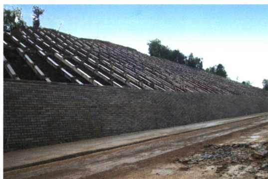
万梁高速公路安龙东滑坡治理工程
