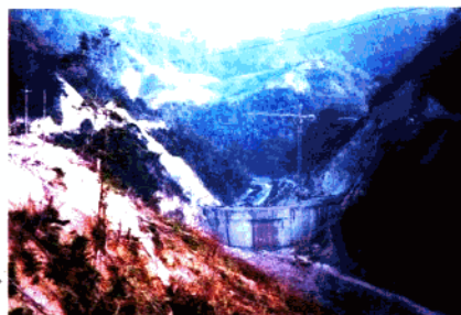
图为承建的德化东园水库电站大坝正在施工
