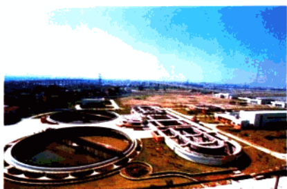
图为承建的泉州宝洲污水处理厂 (2000年10月竣工)
