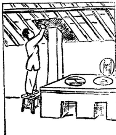
縫時能及時發現進行修補。還有一種是鐵皮做的活動煙囪，大多安裝在鐵爐子上，這種煙囪的特點是傳熱快，使用須特別小心，安裝時節與節之間要接嚴密，用泥灰將縫隙抹死；在屋里的部分離頂棚最少要有一尺半的間距；穿過窗戶部分的周圍要襯上鐵皮隔熱板。它的尺寸最少要相當於煙囪直徑的三倍；屋外部分的出口要高出房簷一尺以上，并加套防火帽，以阻擋和減少火星的飛揚。
