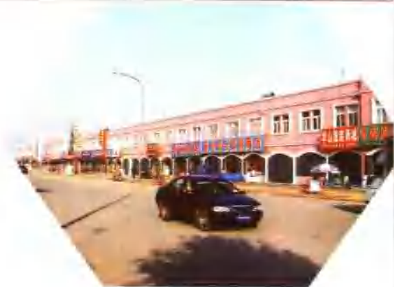
■2005年新建的农场沿街商贸楼。
