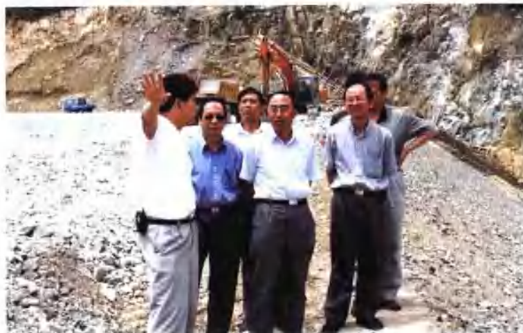
一行长吴再鸣在中国建设银行宁波市分行重点支持的白溪水库建设现场检查工作。
