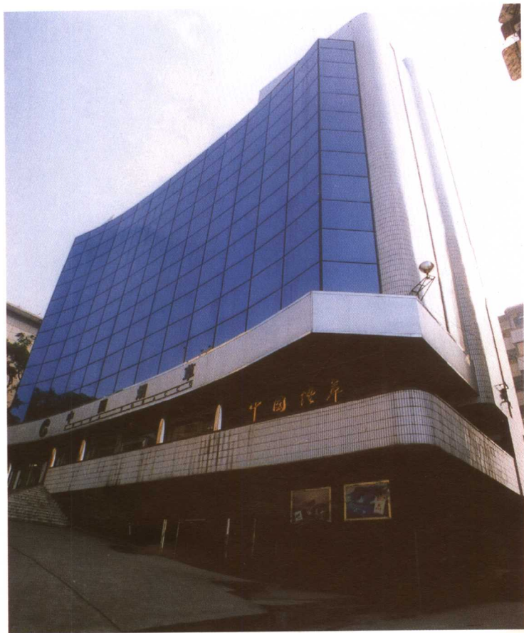
自贡烟草分公司办公大楼
