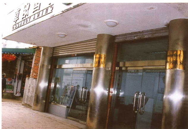
贡井区配送部办公室
