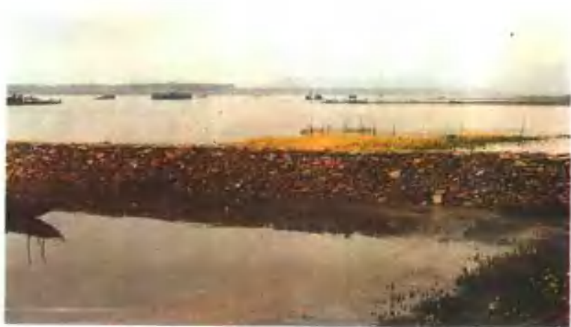
汉江航道整治工程——龙门滩丁坝群
