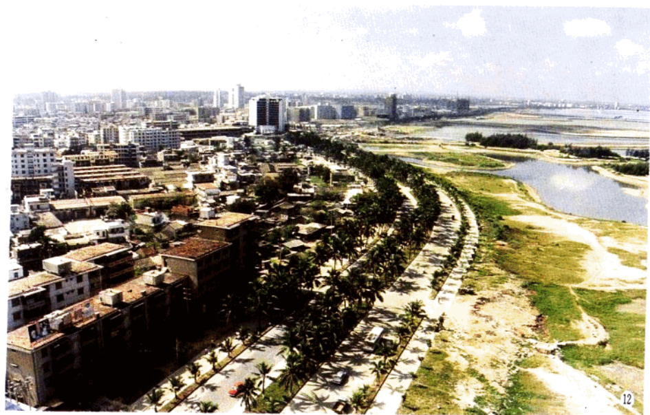
⑫ 建设中的海口市金融贸易开发区。
