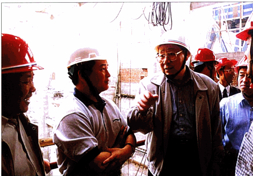
1998年5月31日，水利部副部长张基尧（左三）来枢纽检查工程进展情况
