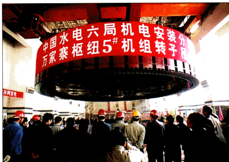
最后一台机组 转子吊装
