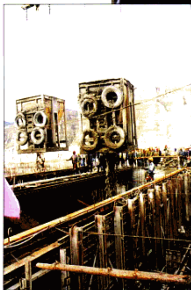
两台缆机同时浇筑混凝土
