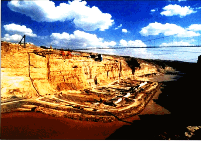
右岸基坑施工现场
