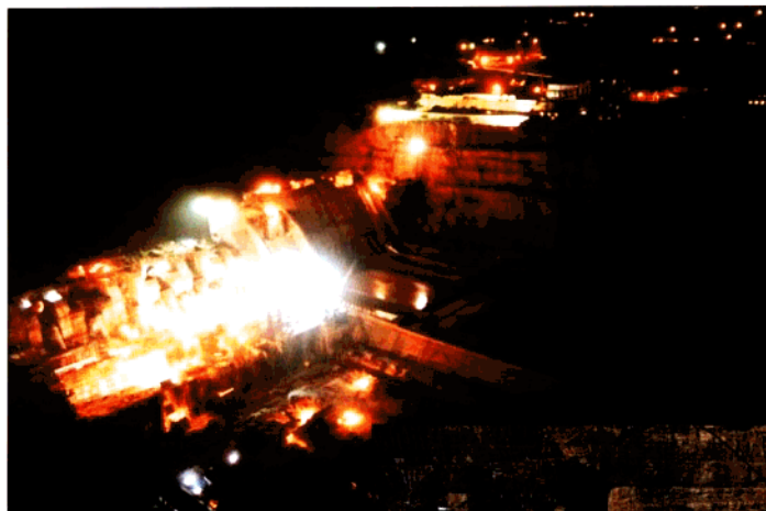
枢纽施工夜景
