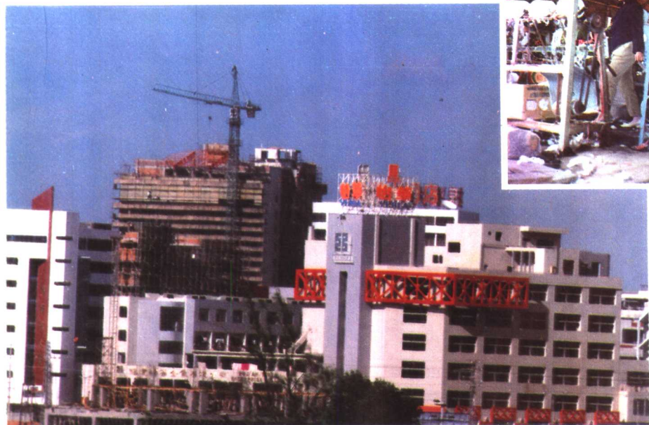
新厂房、新工业园区
