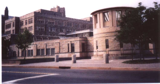
(h)图书馆扩建部分 采用半地下书库及阅览室，层顶为草坪。照片左侧为老馆，右侧为新馆楼梯采光井
