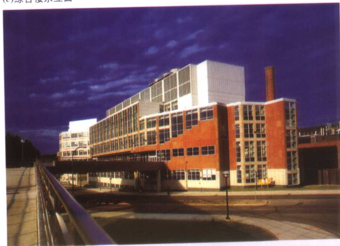
(d) 综合楼北面
