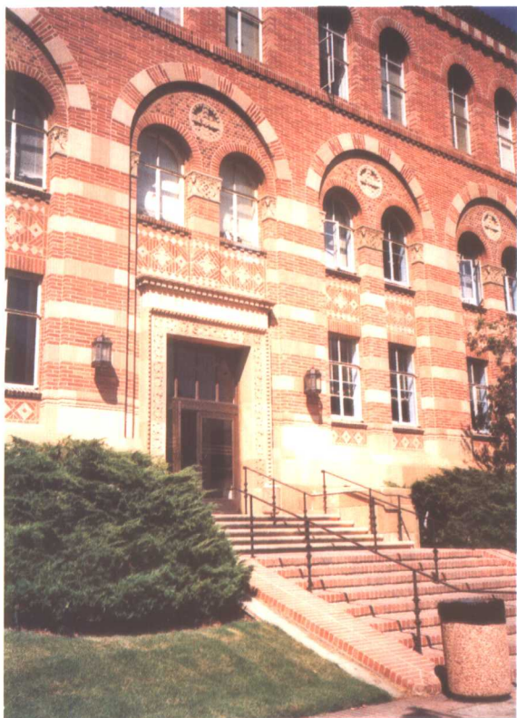
(a)教学楼局部
