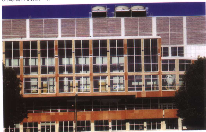
(c) 综合楼东立面
