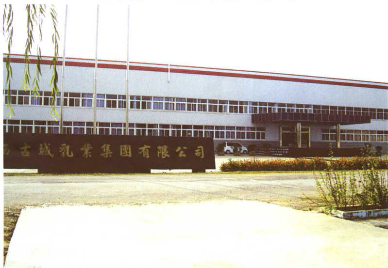
(1) 山西古城乳业集团有限公司新厂正门
