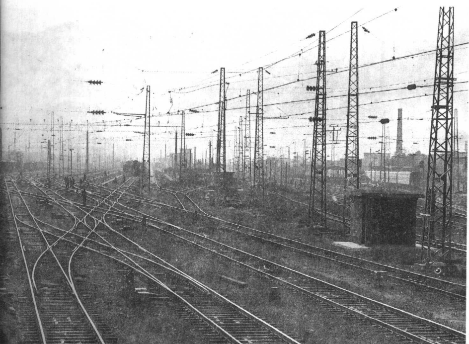
西北最大的电气化车站——兰州西站
