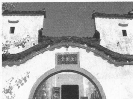
西递村徽派建筑
